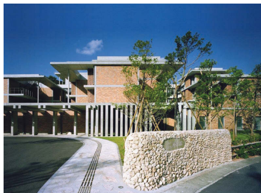
写真 奄美病院外観
