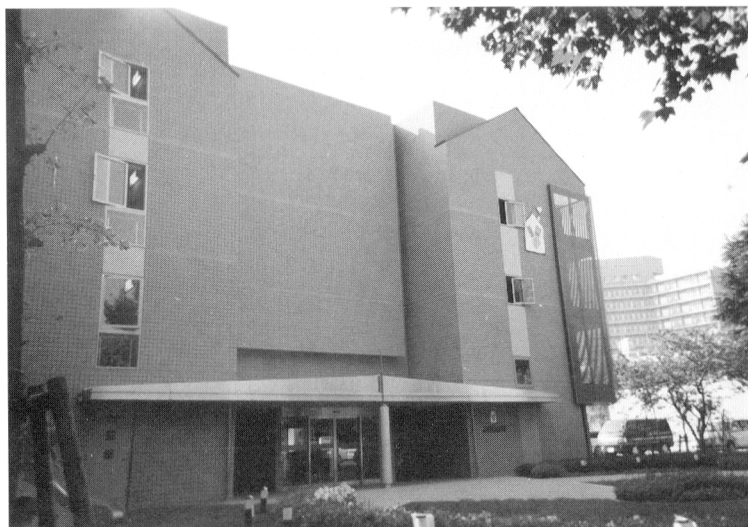
完成したマクドナルド・ハウス。後ろは建設が進む国立成育医療センター(東京・世田谷)
