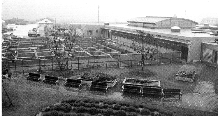
老健施設「やすらぎ」(右)に隣してケア住宅とグループホームの工事が始まった=山形県最上町で
